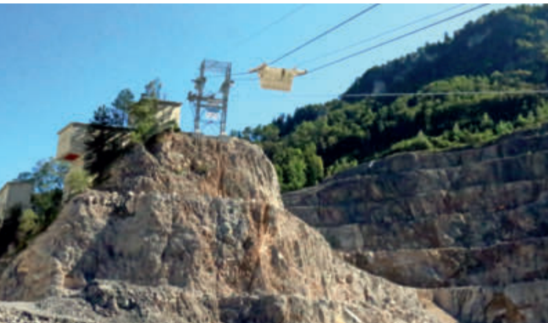
Testfahrt der 25-t-Materialeilbahn im Werksgelände der Kalkwerk Netstal AG (KFN)
