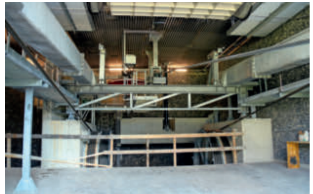
Steinkörbe an der Wand und eine Lavasteinverkleidung an der Decke sorgen für zusätzlichen Lärmschutz in der Bergstation. Im Hintergrund sieht man den 35 t Bewegungskörper aus Beton (= Hydraulikspeicher).
