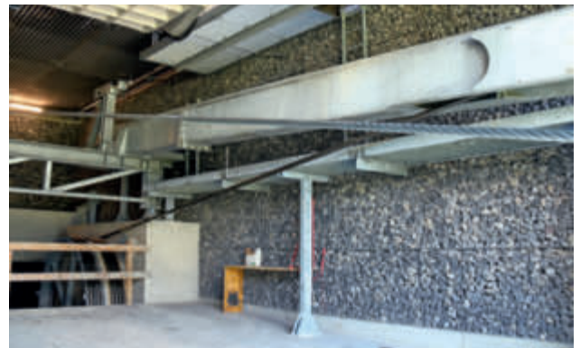
Steinkörbe an der Wand und eine Lavasteinverkleidung an der Decke sorgen für zusätzlichen Lärmschutz in der Bergstation. Im Hintergrund sieht man den 35 t Bewegungskörper aus Beton (= Hydraulikspeicher).
