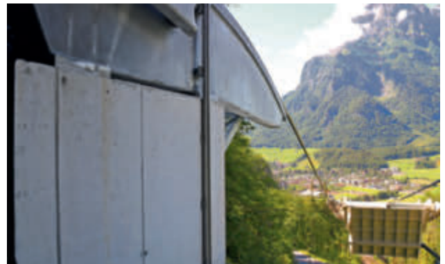
Bergstation: Die Tragseile werden über Sättel schräg nach unten auf die Poller geführt (oben). Während des Befüllungsvorgangs steht das Fahrzeug komplett auf Stahlträgern, um beim Befüllen sicher keine schädlichen Beanspruchungen der Tragseile durch Stöße zu bekommen.
